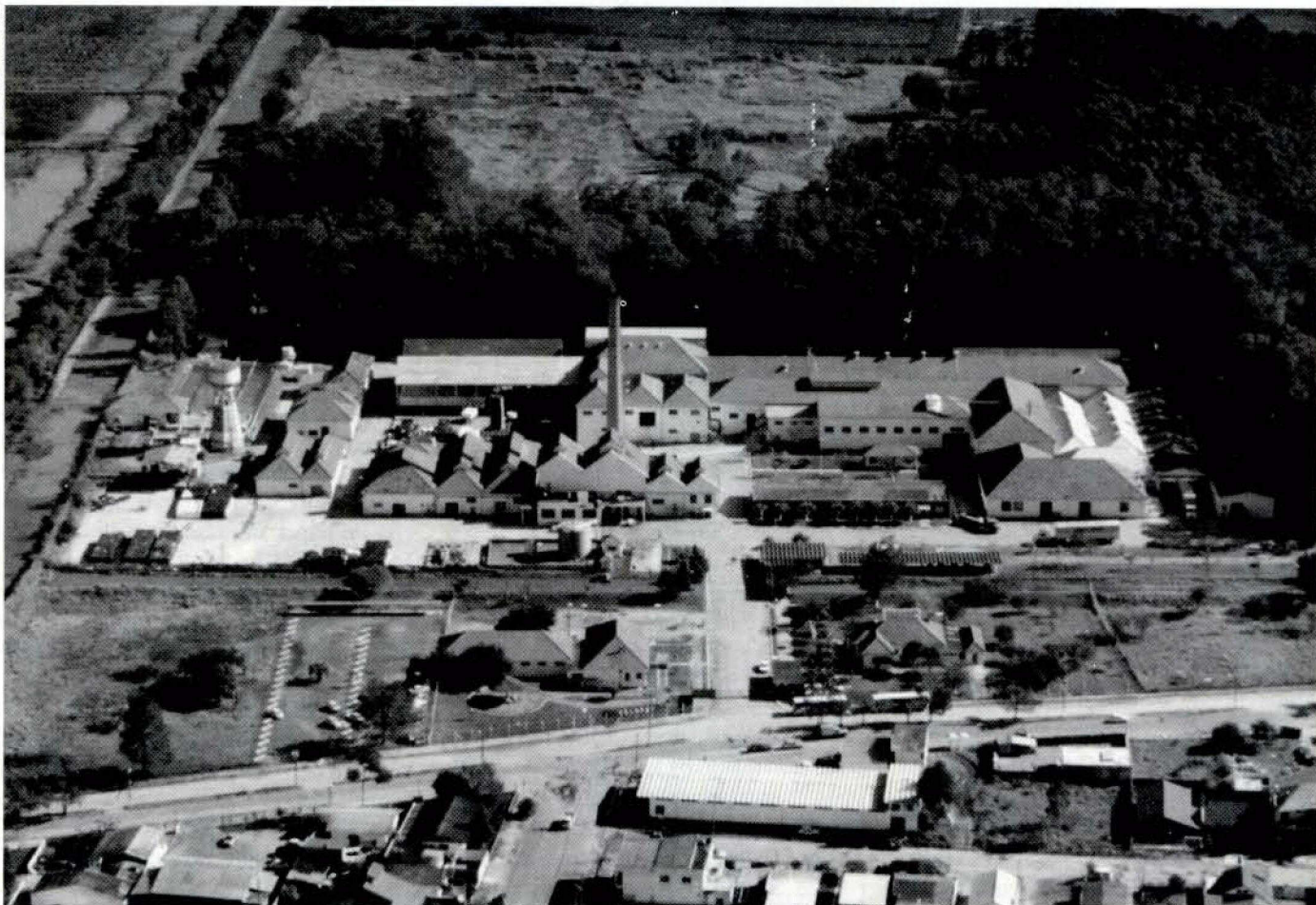
A fábrica da Celupa ocupa uma área de 27.500 metros quadrados
