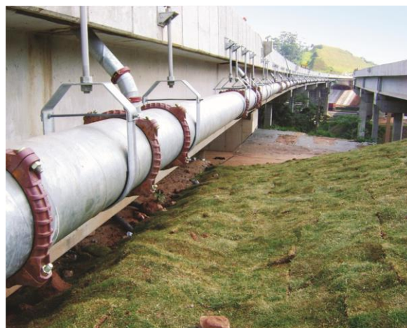
Figura 4 - Uso da solução em obras de infraestrutura.
