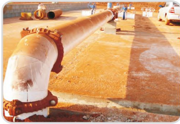
Figura 5 - Tubos revestidos interna e externamente e unidos por acoplamentos.
