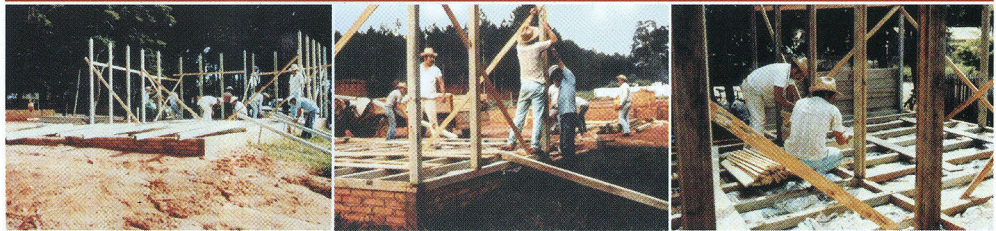
Dia: 3º/4º/5º/6º - Levantamento das paredes internas e externas, colocação das tesouras
