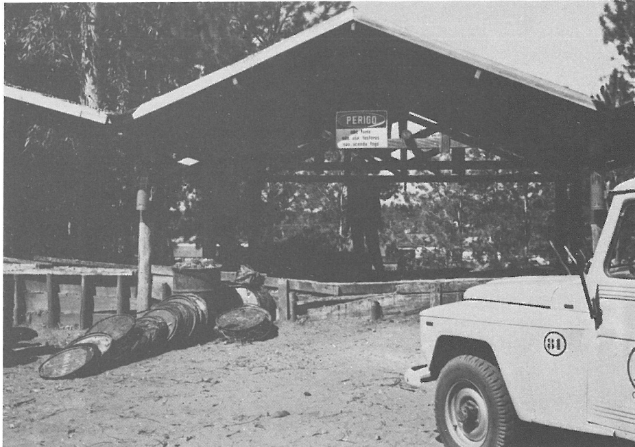
Área de filtragem de resina
