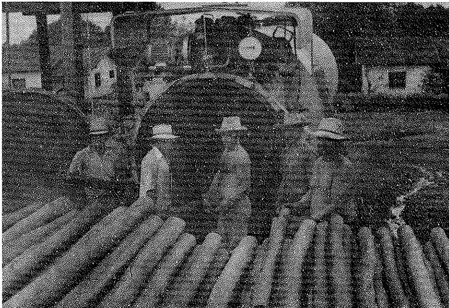
FIGURA 1 — Usina para preservação de madeira
