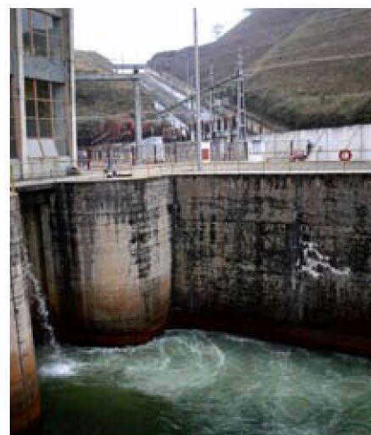
Hidrelétrica de Jaguari, da Companhia Energética de São Paulo (CESP), em plena atividade
