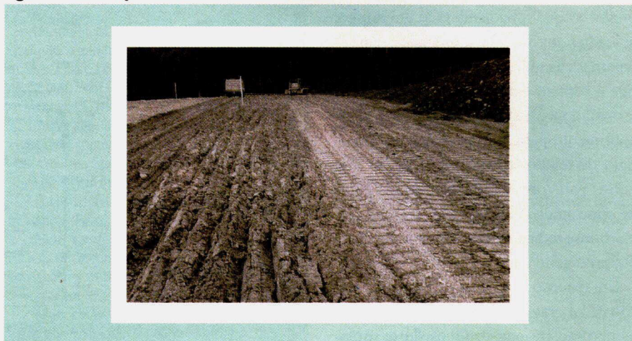
Figura 9 - Construção da camada de resíduos de destintamento no sítio Clinton
