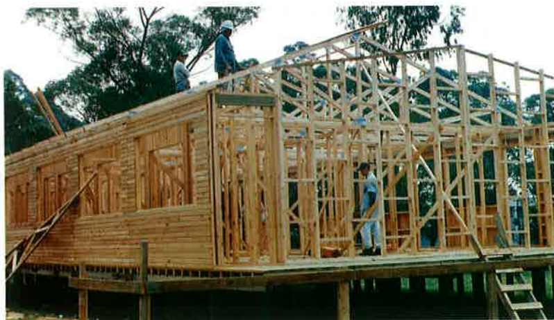
Construção no Instituto de Energia Eletrotécnica (USP) ...
