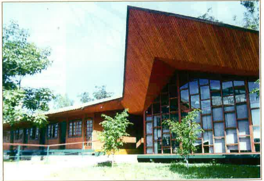
Foto 1 - Os prédios I e II abrigam salas para pesquisadores e Centro de Processamento de Dados.
