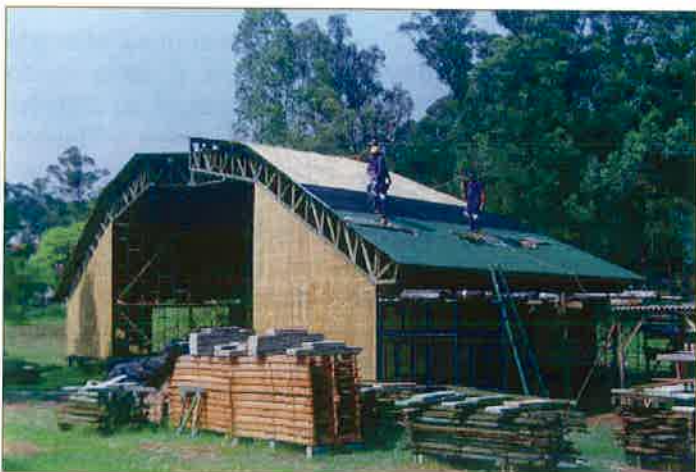
Foto 3 - O Prédio III, na etapa de colocação dos "shingles" asfálticos.
