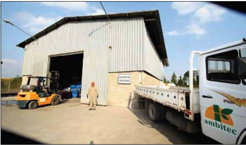
Operação do galpão de armazenamento de resíduos
