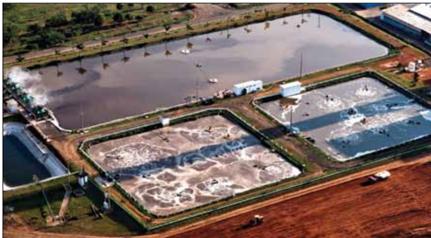
Estação de tratamento de efluentes da Lwarcel: modificações tecnológicas resultaram na diminuição de cloro ativo aplicado à polpa
